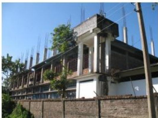
Rückseite des Gebäudes
