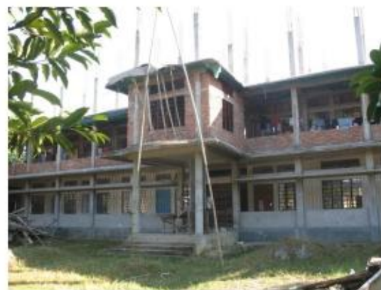
Das Gebäude in der Frontansicht
