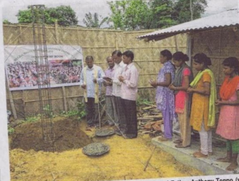
Father Rajesh, Brother Thomas, Father Bimal Lakra und Father Anthony Topno (von links) mit einigen Lehrerinnen bei der Grundsteinlegung für den Freiwilgenraum, den die Seeger Bildungshilfe Nordost-Indien bei der Jyvon Jyoti School in Assam errichten lässt. Foto: Bildungshilfe
