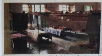
Das Erdgeschoss wird bereits als Unterkunft für einige Bewohner genutzt.
